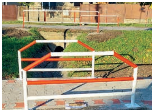
vyčistili jarky a natreli konštrukcie
