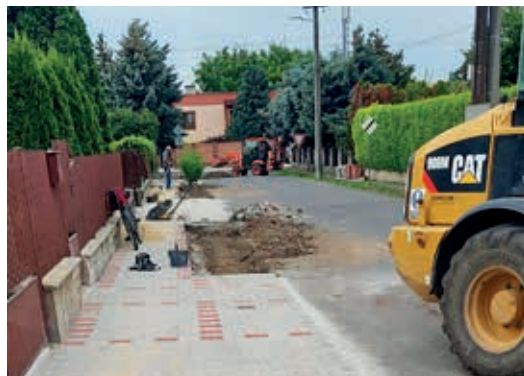
pokračovala výstavba chodníkov - Okružná
